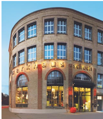
Wo früher Transformatoren gebaut wurden, werden heute neue Arbeitswelten realisiert. Bild: pd.
